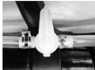
Рис. 8 Установка выпускного шланга на штуцер запорного крана
