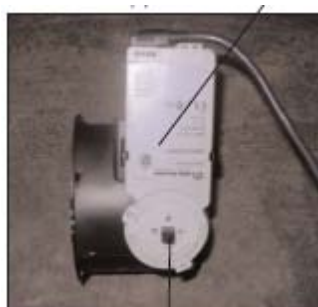
Соединение заслонки с рукояткой (2)
