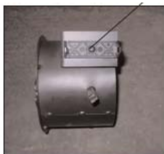
Соединение заслонки с пластиковым кронштейном (1)
